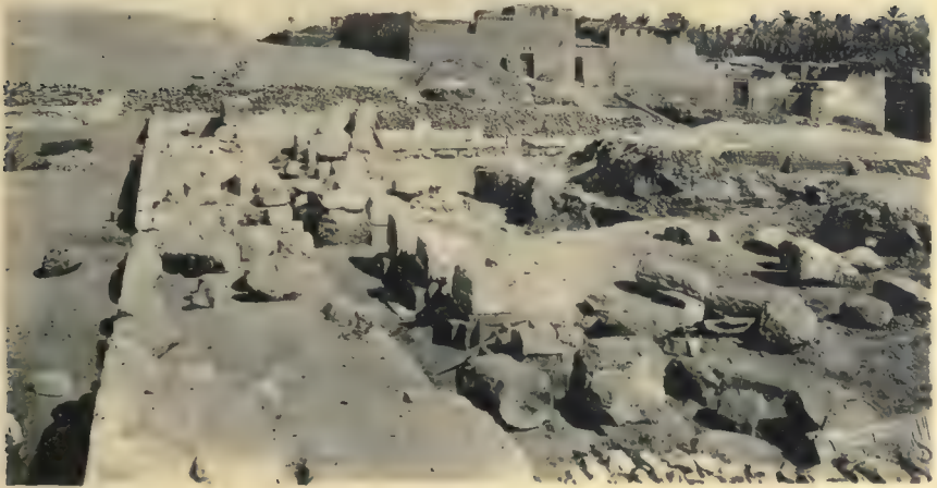
1. Etat des travaux (Mur Ouest et Portique).
